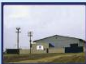
Magasin de stockage de la ZI de Douala - Douala 1000/1001, rue 101 - Douala (Avenue de la Paix)
